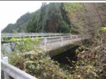
【林道一の水線 橋梁】
