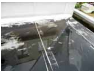
【飛鳥中学校 屋上防水】
