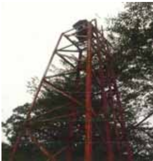
【神川分団サイレン鉄塔】
