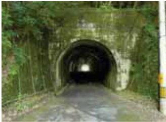
【小川口トンネル】
